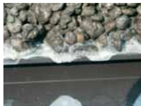
Образование корки препятствует отводу воды
