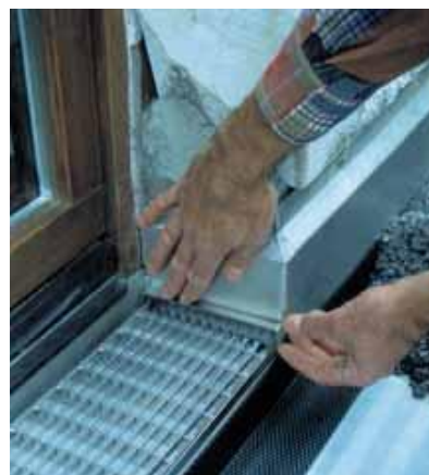
Вставка торцевой крышки
