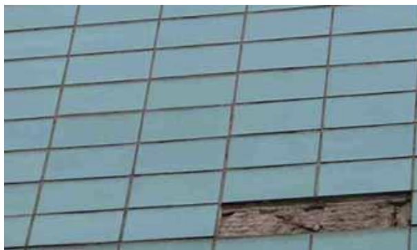
Результат: откалывание покрытия из-за вымерзания
